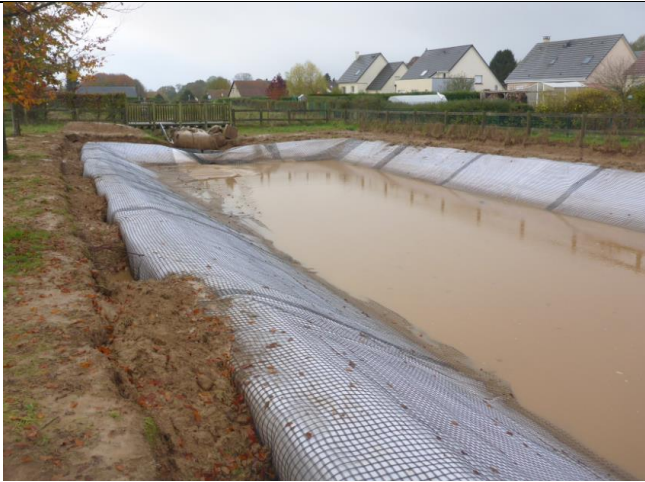
Mise en œuvre d'une géomembrane imperméable + accroche terre sur la totalité de l'emprise du bassin pour prévenir toute nouvelle apparition de bétoires
