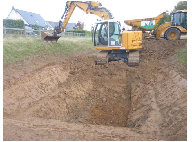
Terrassement de la bétoire et remplissage avec des matériaux compactés
