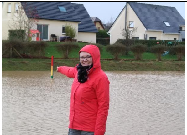
Barrage F_2 à Fresquiennes en phase de décrue. L'eau est montée jusque dans l'orange, ce qui signifie que l'ouvrage était entre 80-100% de sa capacité avant débordement sur la route départementale.
