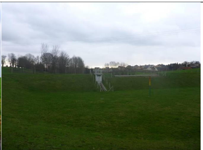
Barrage SP01 situé en aval
