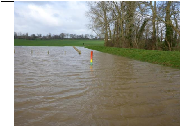
Barrage MP_01b à Mesnil-Panneville au pic de crue Echelle colorée, niveau d'eau dans le vert, ce qui signifie un volume d'eau de compris entre 0-50% de la capacité
