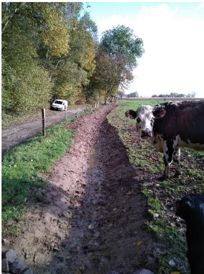
Suppression d'un merlon gênant le bon écoulement de l'eau (agriculteur), à la création d'une noe sur 50 ml et d'un dos d'âne (SMBVAS) et mise en place de deux haies (agriculteur)
