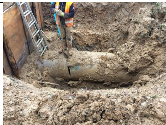
Ouverture d'une fosse pour identifier le dysfonctionnement
