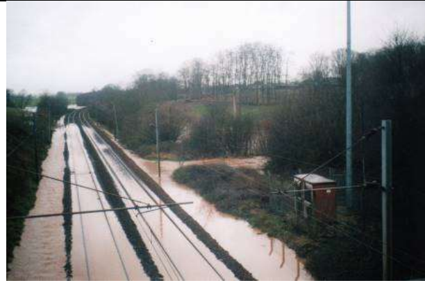
Voie SNCF Paris -Le Havre inondée en décembre 1999 par l'écoulement sur la droite de la photo
