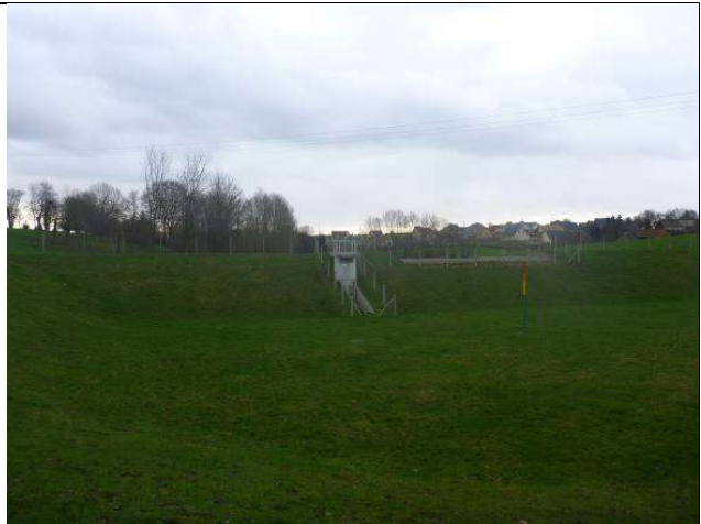
Barrage SP01 situé en aval
