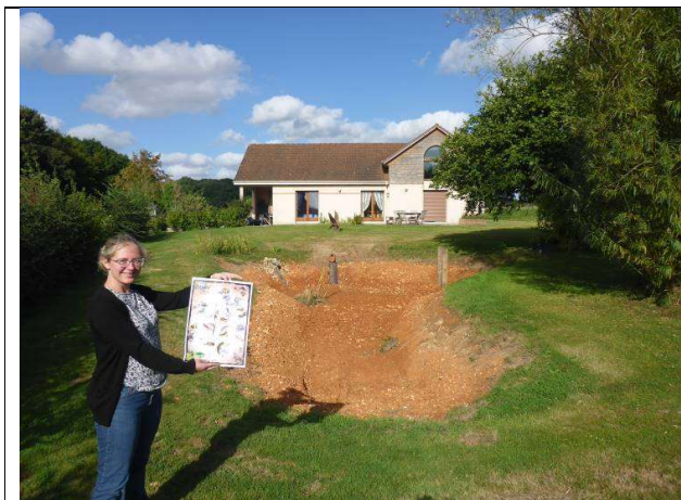
Une première reprise de l'étanchéité avec des argiles n'a pas réussie (trop de silex)
