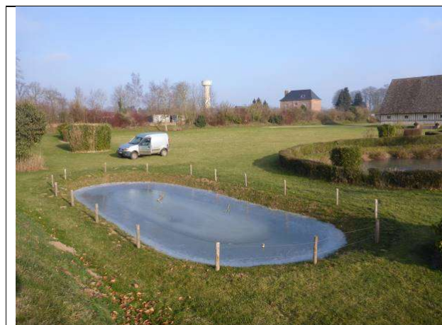
Travaux de sécurisation de la mare pédagogique d'Auzouville-l'Esneval (pentes trop fortes).
