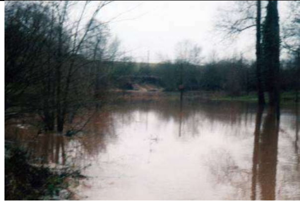
La zone inondable juste en dessous de la voirie pour ce même évènement en décembre 1999
