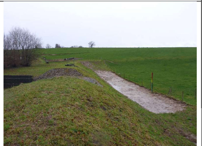
Remise en état de l'ouvrage en octobre 2018
