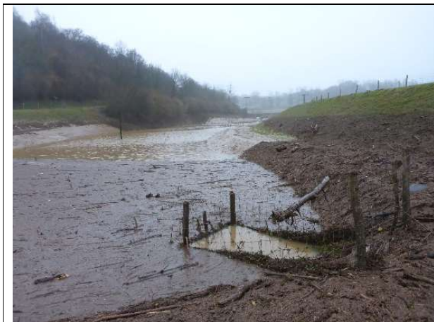
Le barrage pendant la crue du 22 janvier 2018
