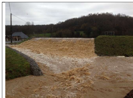
Barrage PP_2-13_2-14 en surverse
