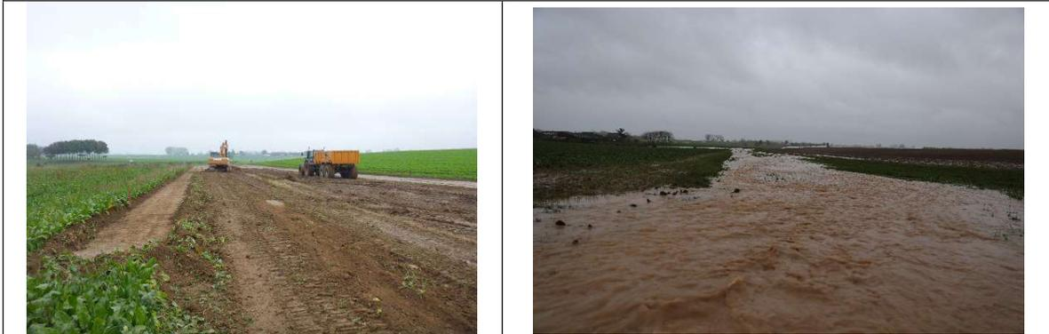
Travaux de réalisation de la noue MP\_03 de 20m de large pour guider les eaux vers notre ouvrage en limitant l'érosion, et mise en fonctionnement de la noue lors de la crue du 11/12/17
