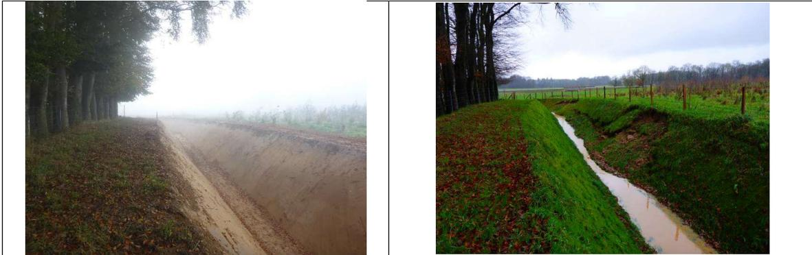
Travaux Fossé MP\_11 de 1 à 3m de profondeur et remplissage du fossé lors de la crue du 11/12/17. Effondrement latéral à reprendre
