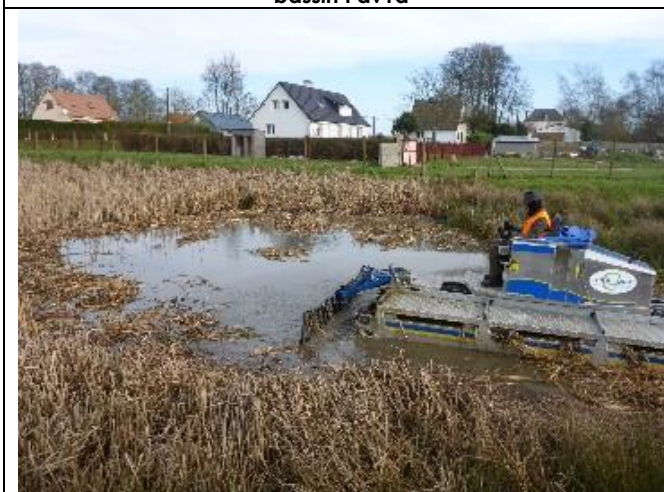
Ectot l'Auber : Arrachage des massettes sur la mare du bassin EA1
