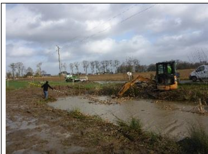
Pavilly : Arrachage des massettes et potamots sur la mare du bassin Pav1a
