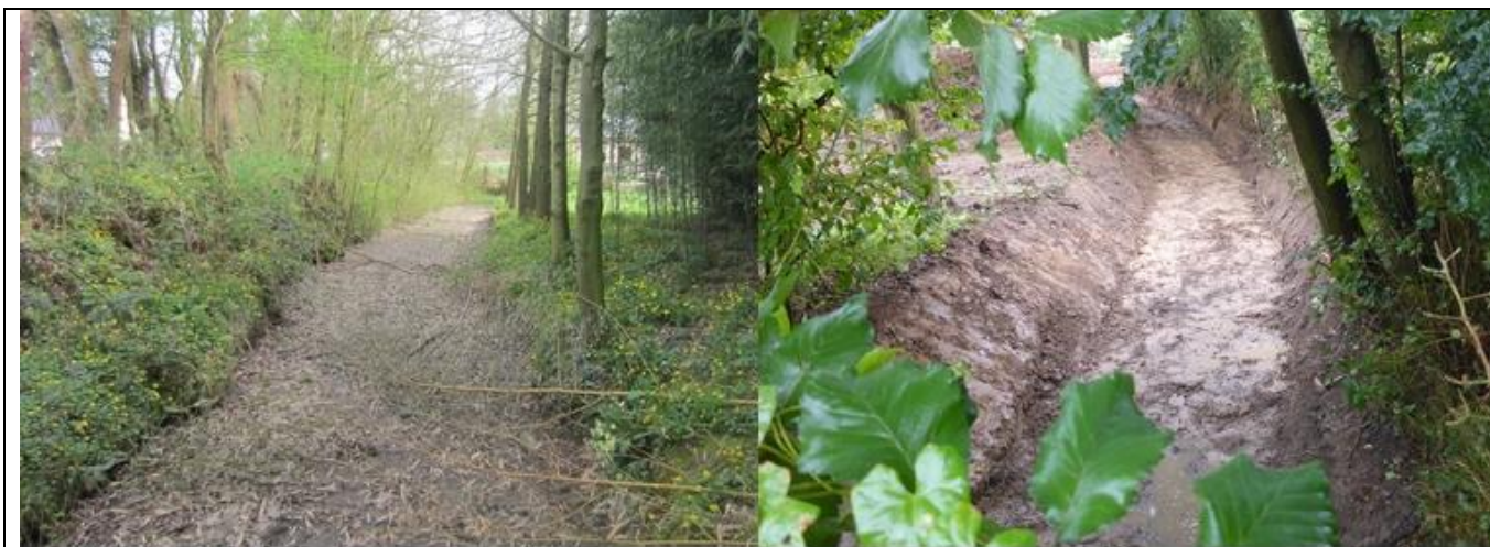
Fossé d'arrivée d'eau avant et après curage
