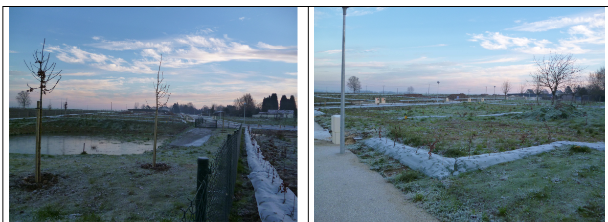
Lotissement communal de PISSY PÔVILLE en chantier
