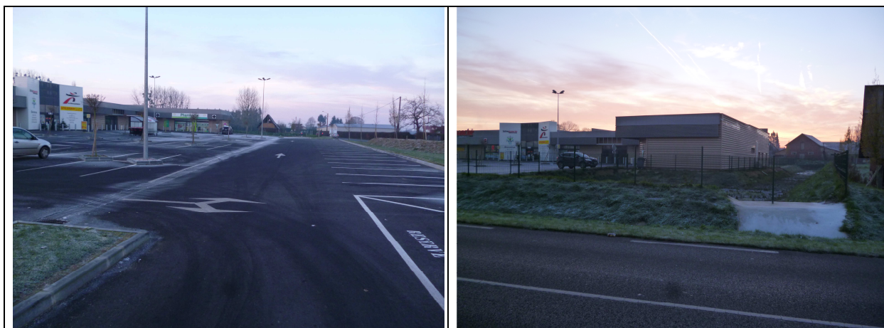
Intermarché – Fin de chantier – ST PIERRE DE VARENGEVILLE
